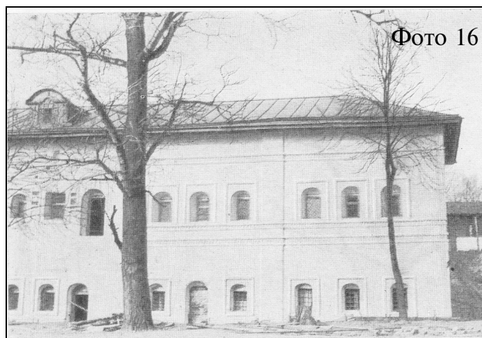
Рис.16. Западные братские кельи XVII в. Северная часть восточного фасада после реставрации.
