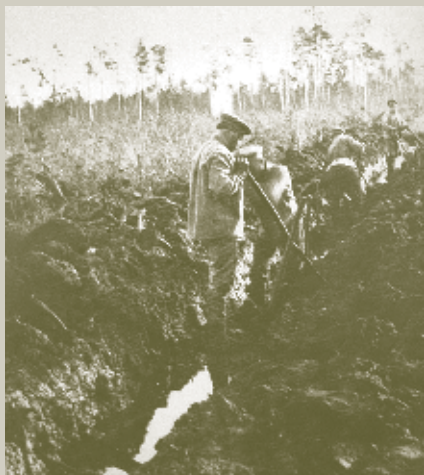
Шатурские Торфопереработки. Дата съемки и автор не известны
